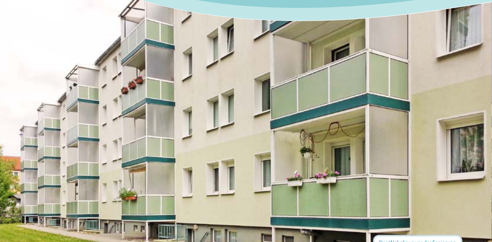
Das Wohnhaus vor der Sanierung
